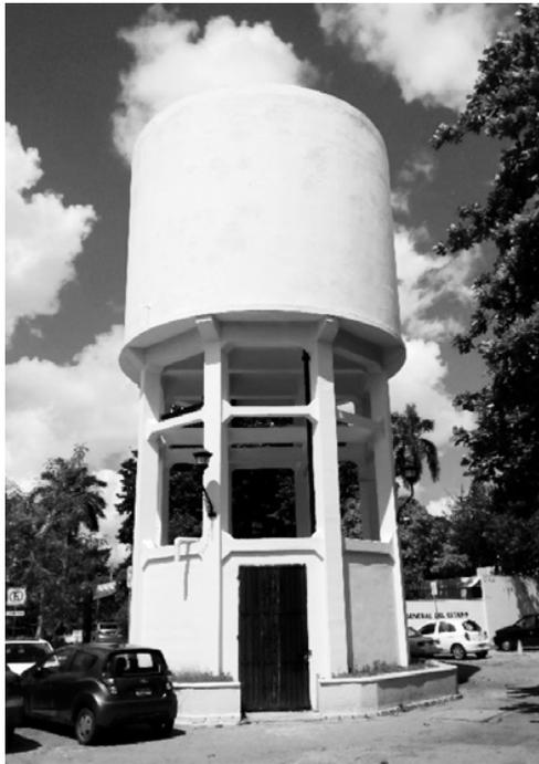
FIGURA 10. Vista del tanque elevado de concreto armado del Hospital O'Horan. Foto del autor, 2017.
