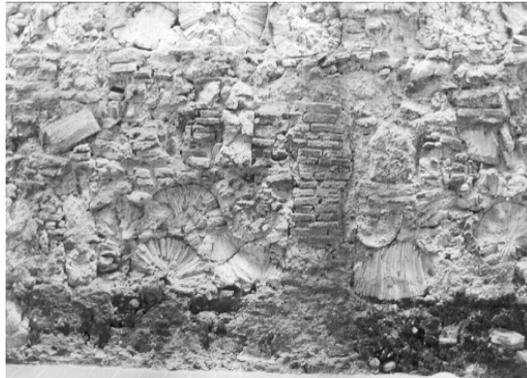
FIGURA 8. Muro de colindancia de mampostería combinada con piedra *muca*, ladrillo y materiales producto de la demolición anterior. Fotografía: Marco Montiel Zacarías.
