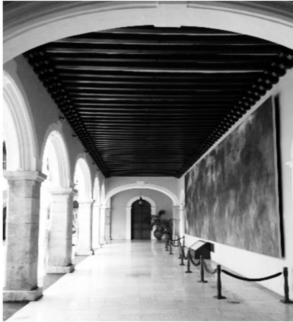
FIGURA 2. Vista de uno de los corredores de planta baja con techumbres de viguería de madera Foto del autor, 2017.
