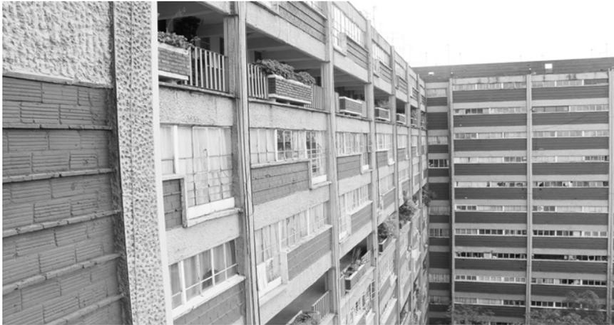
FIGURA 3. En el CUPA, primer conjunto de pensiones civiles, se utilizó el ladrillo rojo recocido para integrar muros exteriores. Fotografía del autor, 2020.<sup>8</sup>
