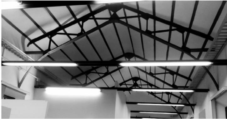
FIGURA 9. Vista de la techumbre de armaduras metálicas y placas de concreto armado en el interior de los pabellones del Hospital O'Horan. Foto del autor, 2017.
