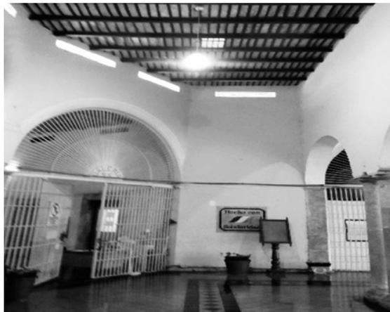
FIGURA 4. Vista del vestíbulo de la planta panóptica con techumbres de viguetas metálicas y viguetillas de madera. Foto del autor, 2017.
