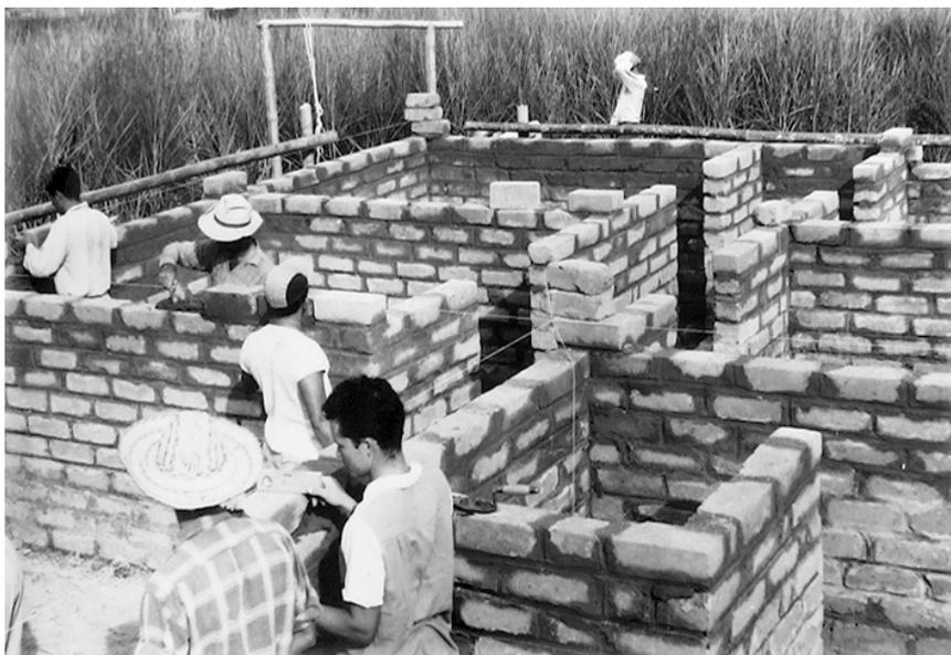
FIGURA 7. Vivienda experimental construida con bloques Cinva-RAM en Chambimbal.
