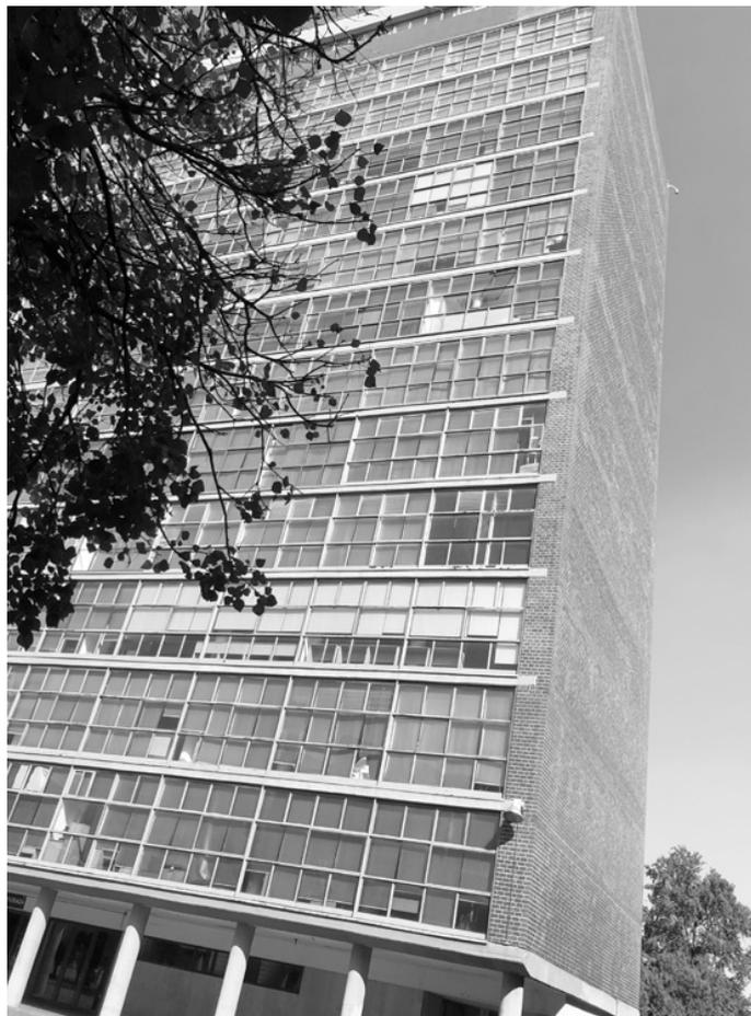
FIGURA 7. Costado sur de la Torre de Ciencias, hoy Torre II de Humanidades, donde el material de la fachada es vitricotta color guinda, que contrasta y se integra con la transparencia de sus ventanales. Fotografía del autor, 2020.
