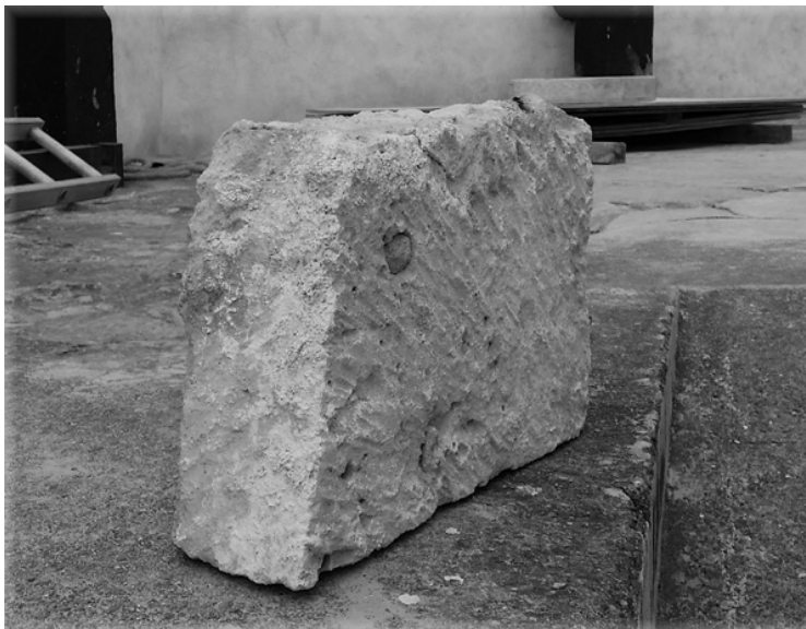
FIGURA 5. Pieza de cantería probablemente de Campeche, empleada como parte del cerramiento de un vano del Baluarte de Santiago (1635) de la ciudad amurallada de Veracruz. Foto de la autora.
