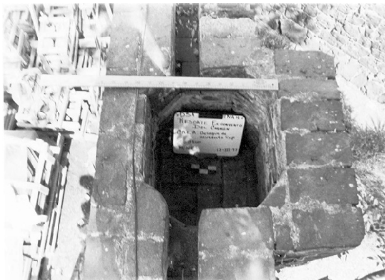
FIGURA 15. Detalle de areneros construidos en el acueducto, María de la Luz Moreno, op. cit.
