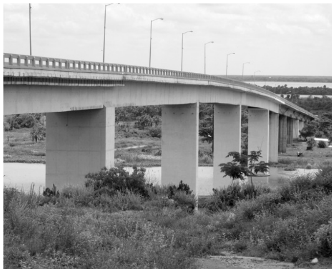
FIGURA 15. Puente de Tlacotalpan, foto del autor.
