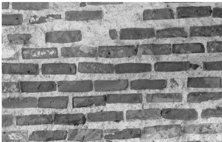
FIGURA 6. Ladrillo en las rosas de bóvedas de la cortadura de San Fernando, en San Juan de Ulúa. Foto de la autora.
