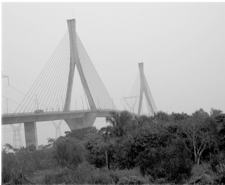
FIGURA 16. El puente Antonio Dovali Jaime (Coatzacoalcos II), foto del autor.
