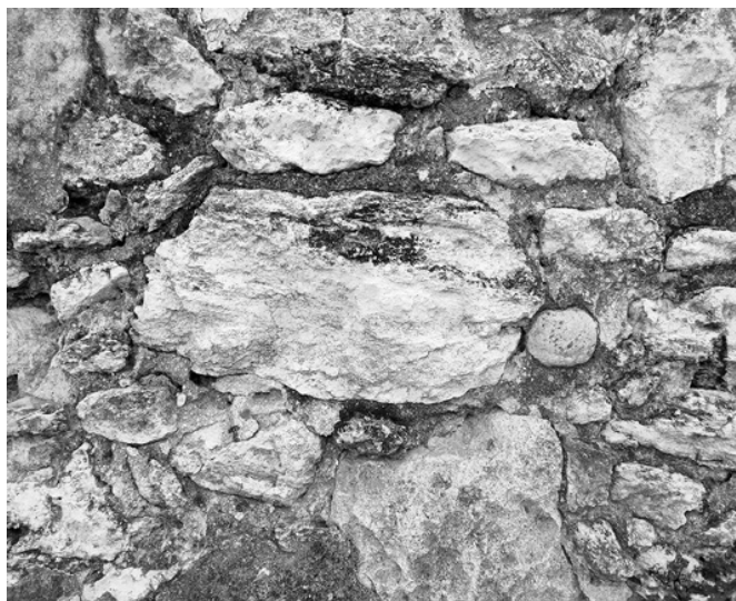
FIGURA 4. Mampostería de calizas en el parapeto del Fortín de las Órdenes Militares de Plan del Río, foto de la autora.
