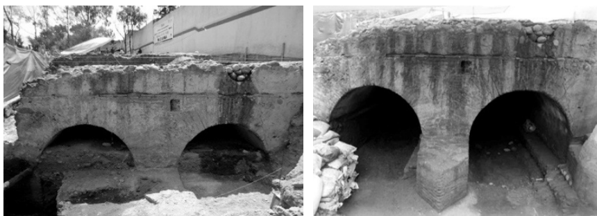
FIGURAS 18a y 18b. Izquierda, se muestra el azolve de los cárcamos; derecha, los cárcamos desazolvados, fotografías de la autora, 2014.
