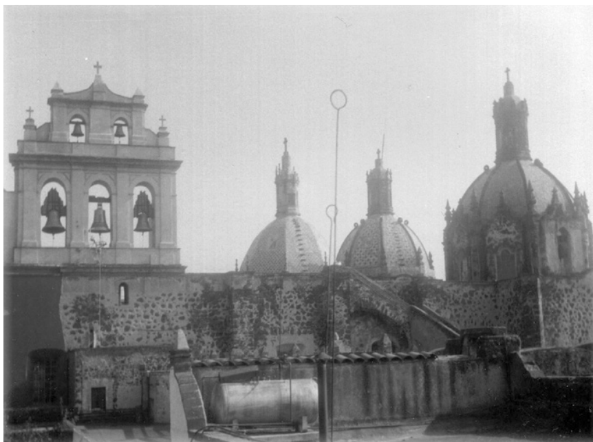
FIGURA 4. Convento y templo de los carmelitas en San Ángel. Se observa el sistema de captación de agua pluvial en la techumbre. Fotografía: María de Lourdes López, op. cit.
