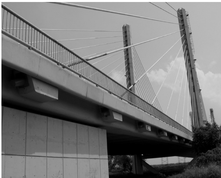
FIGURA 14. Puente de 1995 sobre el río Papaloapan, foto del autor.
