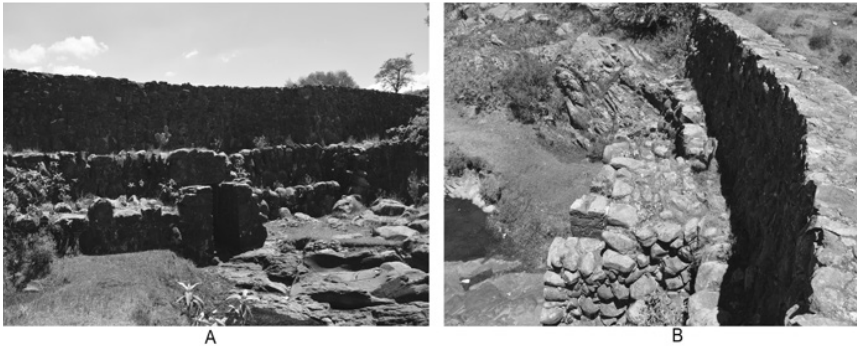
IMÁGENES 11a y 11b. Cortina de la presa II. A. Vista interior de la cortina en donde se observa el abrigo rocoso que sirve de apoyo. B. Parte interior en donde se observan los tres cuerpos y la compuerta. Fotografías de Mauricio A. Lovera Limberg.
