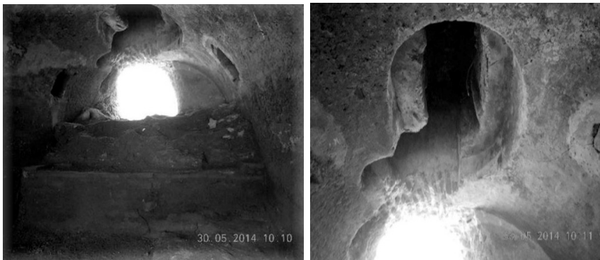
FIGURAS 21a y 21b. Izquierda, meseta para el rodezmo; derecha, huella en el techo por donde salía el árbol que conectaba con las piedras de molienda, fotografías de la autora, 2014.
