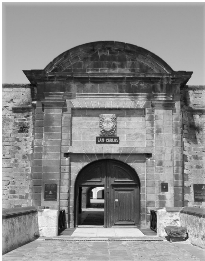
FIGURA 2. Portada de acceso a la fortaleza de San Carlos en Perote, donde se observa el trabajo de cantería realizado con piedra basáltica de la región, foto de la autora.
