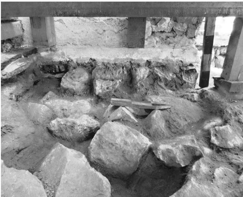
FIGURAS 15a y 15b. Anterior: vista del cimiento del pilar SW en el que se aprecia la aplicación de una sustancia negra. Arriba: vista del desplante del contrafuerte
