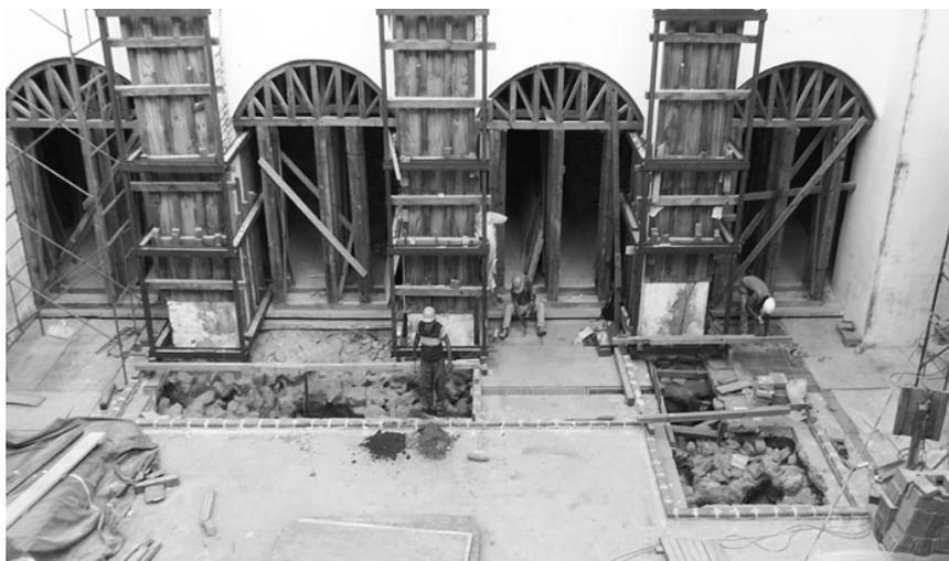
FIGURA 5. Vista de los pozos de sondeo en torno a los contrafuertes del lado poniente del patio central del claustro. De derecha a izquierda, contrafuertes 1, 2 y 3. Fotografía: Sección de Arqueología, INAH Oaxaca.
