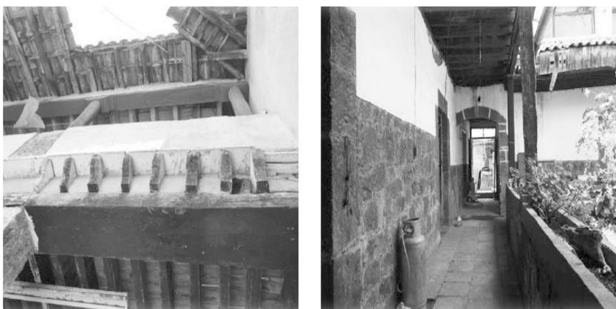
FIGURAS 11a y 11b. Izquierda: vista de sistema de cubierta y entepiso en vivienda; derecha: corredor interior. Se observa muro de piedra y entepiso de viguera.
