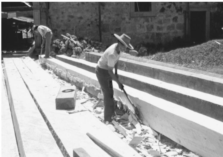
FIGURA 4. Angareros (artesanos que realizan la escuadría de la madera por medio del hacha y el hachazuela), elaborando las grandes vigas para la construcción.
