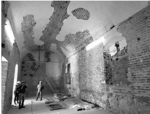
FIGURAS 16a y 16b. Arriba: contrafuertes-pilares. Abajo: muros y bóvedas en la planta baja del claustro del exconvento. En algunos muros de la planta baja se pueden apreciar arranques de distinta fábrica. Fotografía 16a: Sección de Arqueología, INAH Oaxaca; fotografía 16b: Mena Gallegos.
