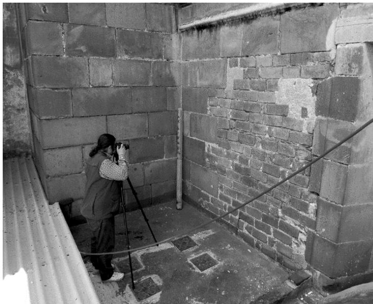
FIGURA 16. Muro este de la catedral de Puebla (cabecera) en el que se aprecian los dos tipos de sillares: prehispánico y castellano (foto de Sotero Ruiz y Antonio Molero).
