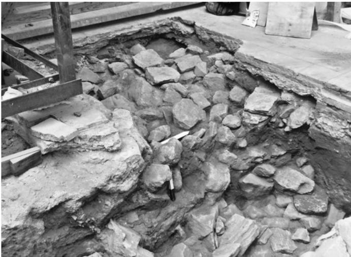
FIGURAS 14a y 14b. Arriba: vista de oriente a poniente del talud de piedra y de tierra entre los contrafuertes 2 y 3; abajo: vista entre el contrafuerte 1 y el pilar NW; en esta última se aprecia del lado izquierdo el cimiento del contrafuerte 1.
