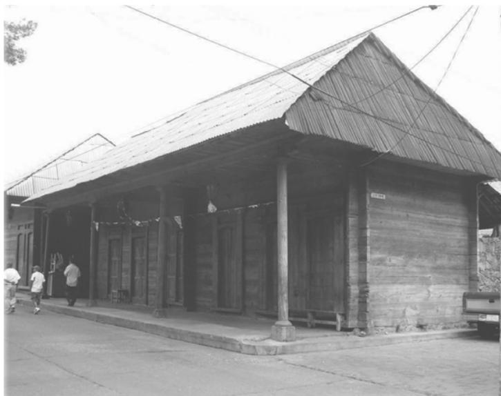
FIGURA 9. Otro ejemplo que demuestra las variantes de viviendas elaboradas con madera ensamblada. Fotografía: Luis Torres G., 2004.
