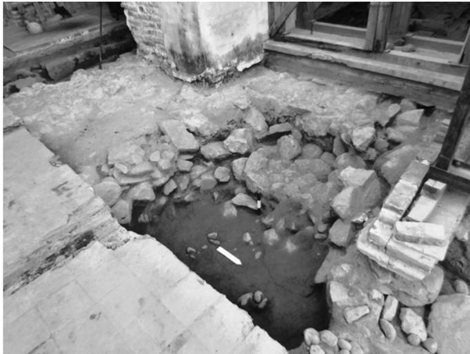
FIGURA 12. Vista de noreste a suroeste de las contratraves de liga en el pilar SW. Fotografía: Sección de Arqueología, INAH Oaxaca.
