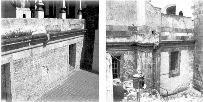
FIGURAS 18a y 18b. Izquierda: muro sur; derecha: muro este de la catedral de Puebla donde se aprecian los dos tipos de sillares: prehispánico y castellano (Fotos de Antonio Molero).
