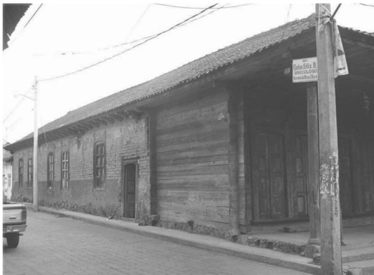
FIGURA 8. Casa habitación elaborada con tablonces de madera ensamblada, ligada a edificación con muros de adobes. Fotografía: Luis Torres G., 2004.
