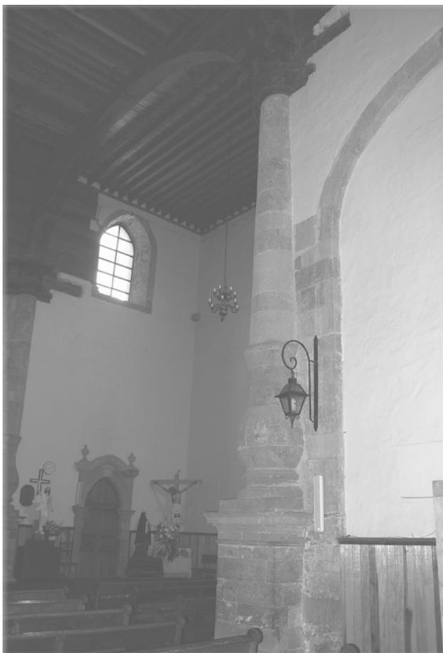
FIGURA 17. Pilastras pareadas de soporte del crucero. Fotografía: Luis Torres G., 2004.
