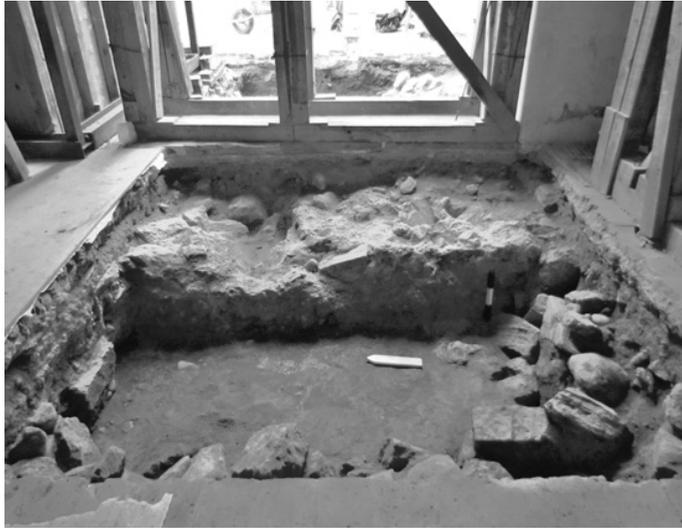
FIGURAS 11a y 11b. Anterior: vista de oriente a poniente del cimiento del contrafuerte 1. Arriba: vista de poniente a oriente de la contratrabe de liga entre el contrafuerte 3 y el pilar SW. Fotografías: Sección de Arqueología, INAH Oaxaca.
