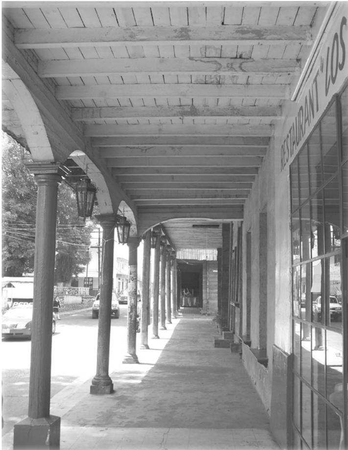
FIGURA 7. Portales frente a la plaza de Charapan solucionados con el sistema de zaparas de madera. Fotografía: Luis Torres G., 2004.
