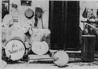
ELCINEMATOGRÁFICO de cómo quedaron las instalaciones de los señores de la Arena Xalapa.
