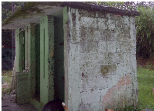
Letrinas. Proceso de cambio de ubicación de fosa séptica
