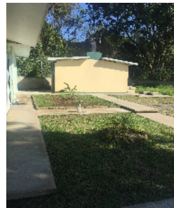
Obra sanitaria automatizada. Noviembre de 2015
