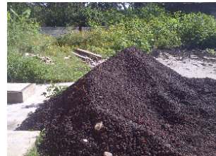
Prosigue construcción de salón de usos múltiples
