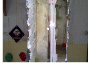
Interior del aula y acceso por un costado a letrinas
