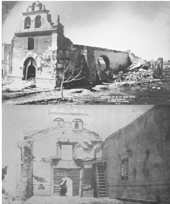
IMAGEN 7. Daños en el templo, durante el huracán de 1918.
