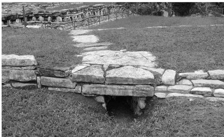
Fig.. 4. Dren para control del agua.
