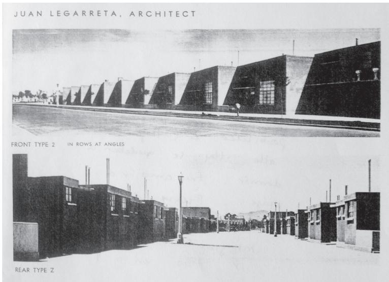
FIGURA 6.4. Las “casas mínimas” para obreros de la colonia Balbuena estaban organizadas en filas bajo un arreglo llamado *Siedlungen-Zeilenbau* (asentamientos de construcción en línea) que se había utilizado en Alemania y en Austria. En la foto pueden apreciarse las chimeneas para las campanas de tiro.
