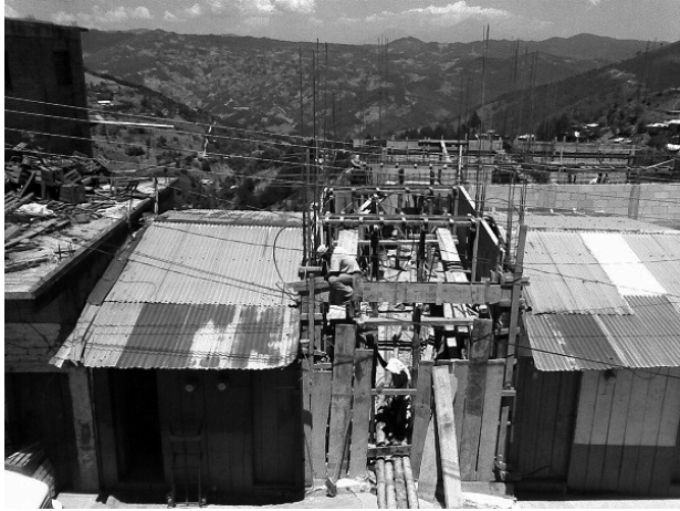
FOTO 16. Nativos de Tehuipango edificando una casa en la cabecera municipal. (Fotografía: Alejandro Martínez Canales.)
