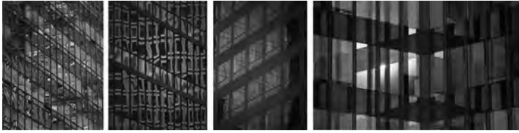
Figura 98. Brillos y reflejos característicos de las fachadas de edificios tratadas con vidrios espejo o muy reflectantes, que desmaterializan visualmente su volumetría.
