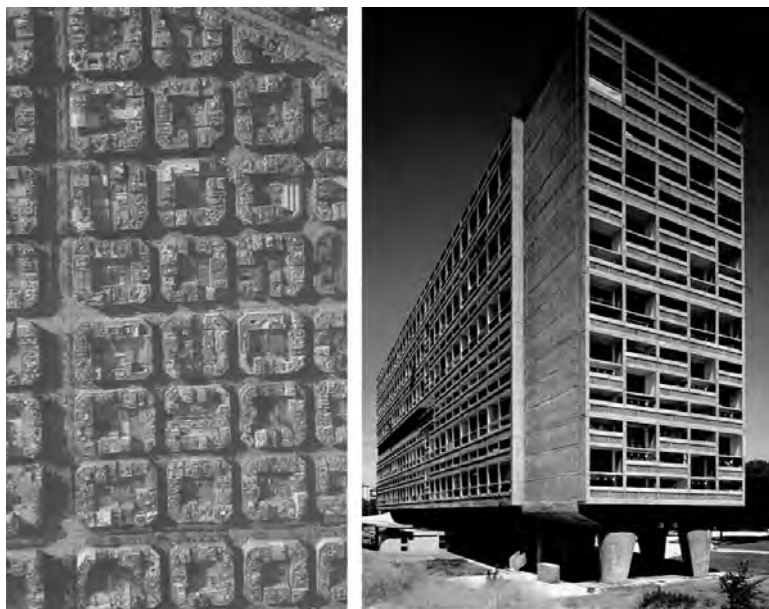
Figura 74. Diferentes conceptos de habitar y diferentes formas arquitectónicas que les dan respuesta. Habitación densificada y de poca altura en el “ensanche” de Barcelona, 1859, y viviendas en altura de la Unidad Habitacional de Marsella, de Le Corbusier, 1945.
