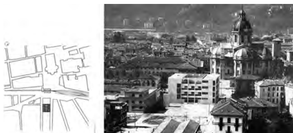
Figura 140. Casa del Fascio, de Terragni, integrada al contexto histórico de Como. Planta de Clark y Pause.
