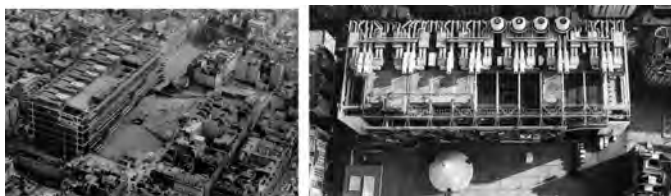
Figura 141. El polémico Centro Pompidou, integrado volumétricamente –en altura y alineamiento de fachadas– pero separado de su contexto decimonónico en su tratamiento plástico, maraña de tubos de colores.
