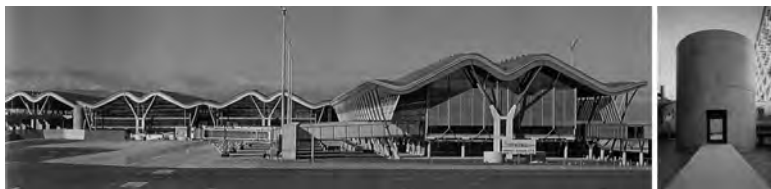
Figura 33. El oficio es indispensable en toda obra arquitectónica, no sólo en las de gran escala. En estos ejemplos está presente tanto en el enorme aeropuerto de Barajas, de Richard Rogers, como en el pequeño Espacio de Meditación de la UNESCO, de Tadao Ando.
