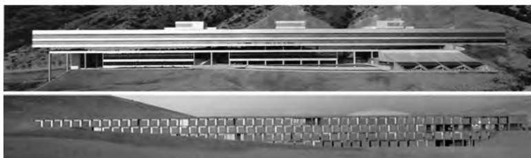
Figura 12. Formas arquitectónicas cuya dirección horizontal las afianza a la tierra sobre la cual se desplantan.
