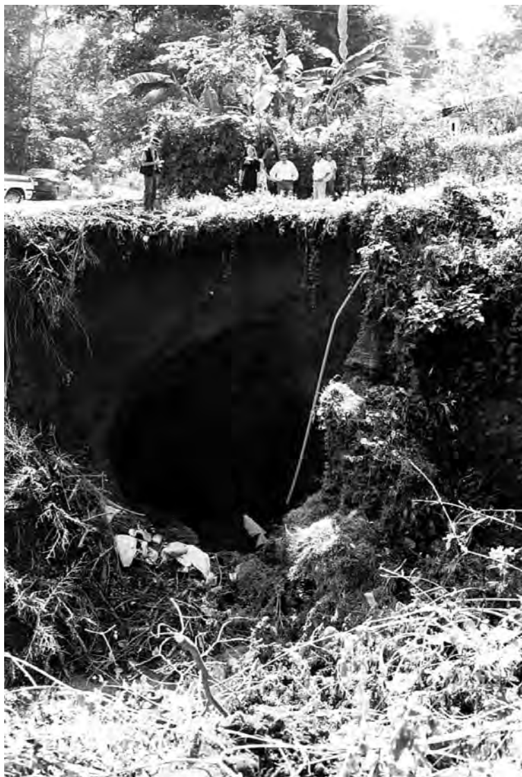
Figura 43. Imagen de una de las cavernas de disolución en la población de Tezonapa. Nótese las dimensiones de acuerdo con la escala de las personas (fotografía J. L. Murrieta).
